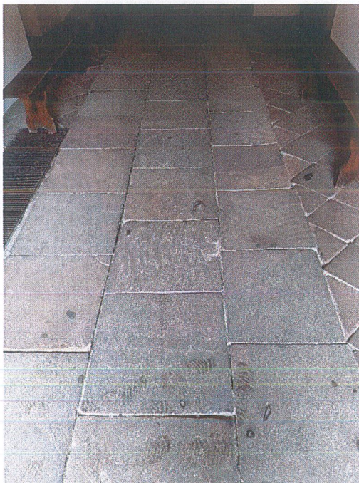
Ogólny widok na posadzkę
