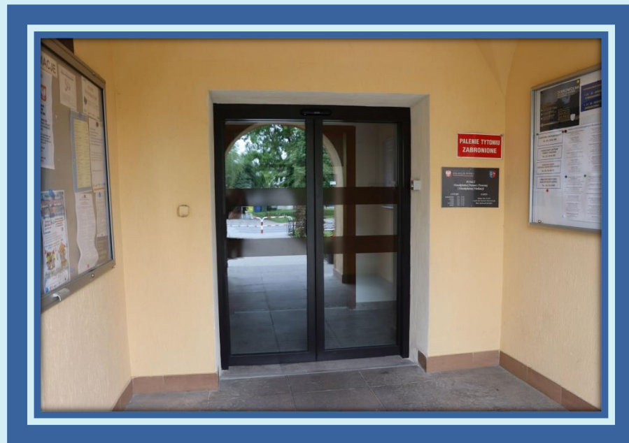
Nowe drzwi wejściowe
