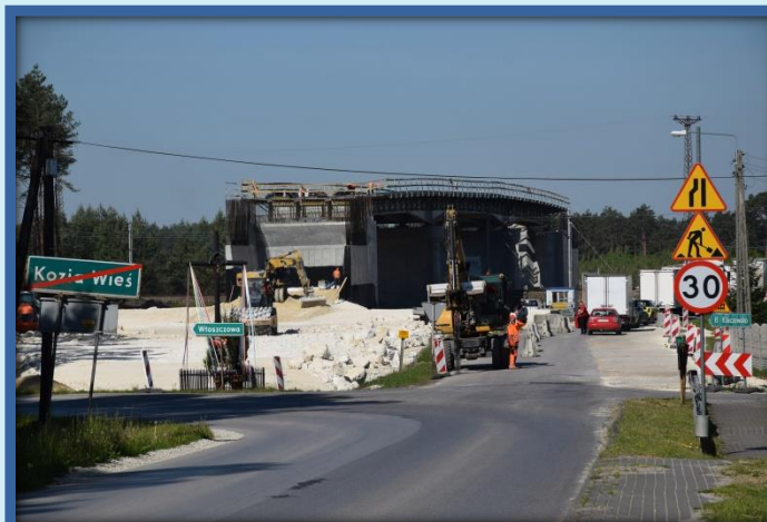
Wiadukt w Koziej Wsi w trakcie budowy – 4 czerwca 2020 r.
