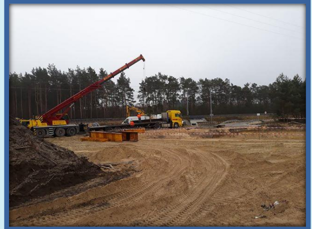
Początek budowy wiaduktu w Koziej Wsi – 27 stycznia 2020 r.
