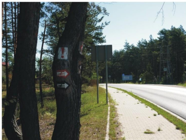
PRZED BUDOWĄ OBWODNICY WŁOSZCZOWY
