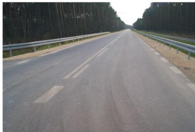
ODDANA DO UŻYTKU OBWODNICA
