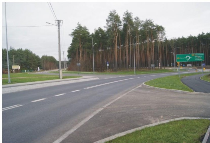
ODDANA DO UŻYTKU OBWODNICA
