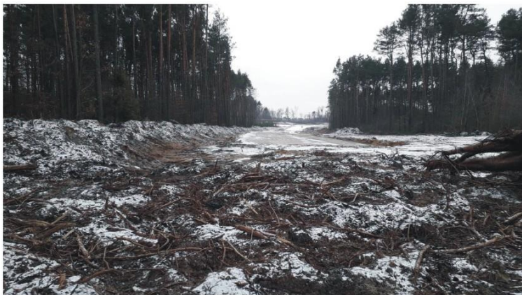
PRZED BUDOWĄ OBWODNICY WŁOSZCZOWY
