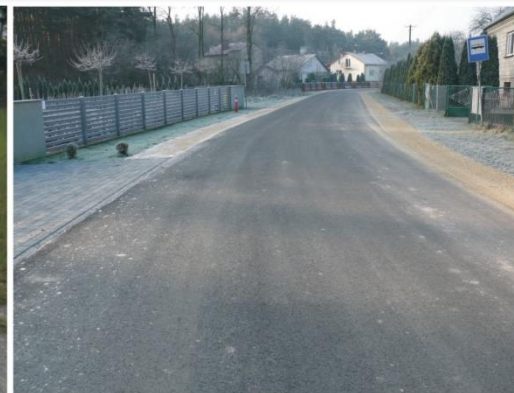
DROGA PO REMONCIE
