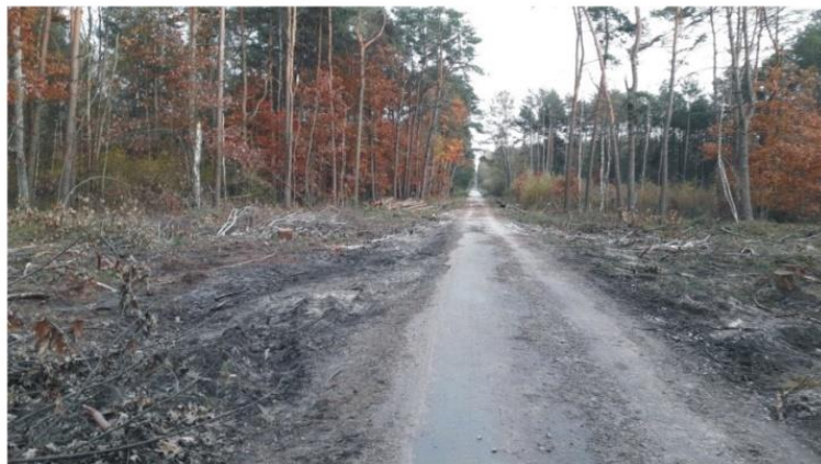
PRZED BUDOWĄ OBWODNICY WŁOSZCZOWY
