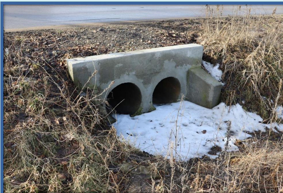
Przepust pod drogą powiatową Nr 0233T w miejscowości Czaryż po remoncie
