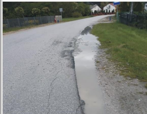
DROGA PRZED REMONTEM
