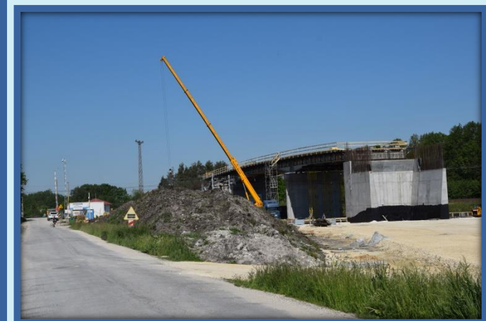
Wiadukt w Motycznie w trakcie budowy – 4 czerwca 2020 r.
