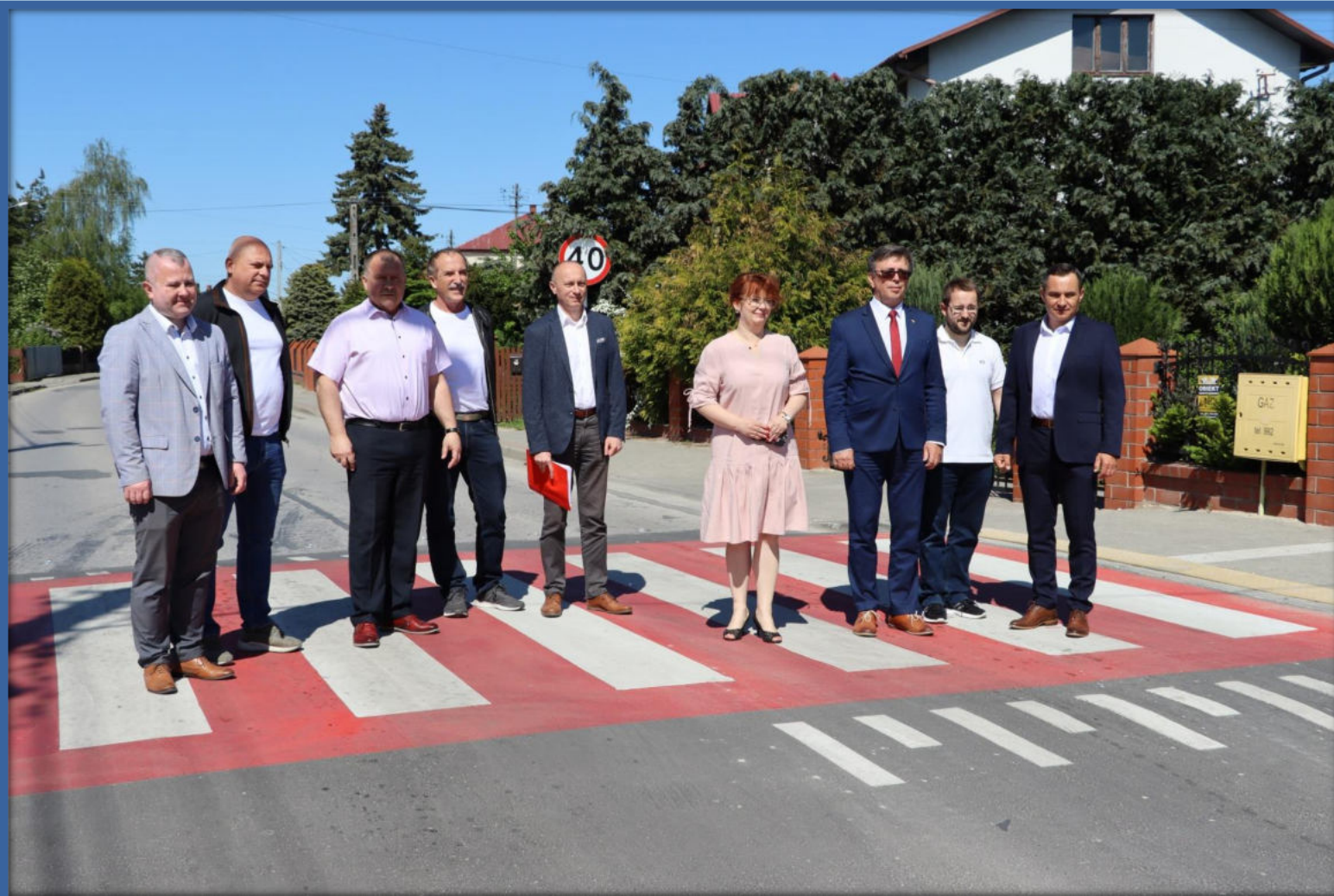
Odbiór wybudowanego przejścia dla pieszych na ul. Wschodniej we Włoszczowie w dniu 18 maja 2022 r.
