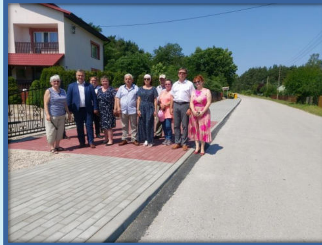
Odbiór wybudowanego chodnika – 1 lipca 2022 r.
