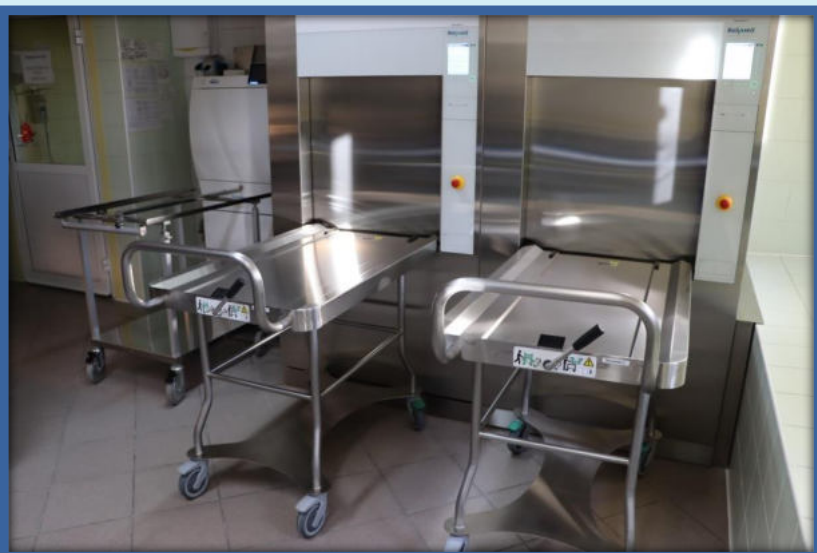
Centralna Sterylizatornia po remoncie
