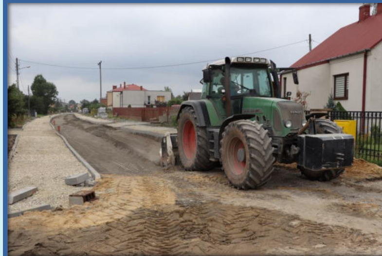
Ul. Ogrodowa we Włoszczowie w trakcie rozbudowy – 2 sierpnia 2022 r.
