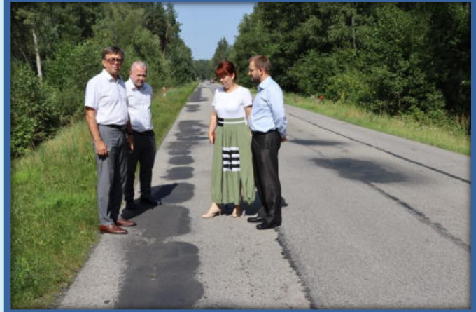
Wizytacja drogi przed rozpoczęciem robót – 25 sierpnia 2022 r.
