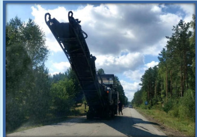
Droga powiatowa Nr 1442T w trakcie przebudowy – 29 sierpnia 2022 r.
